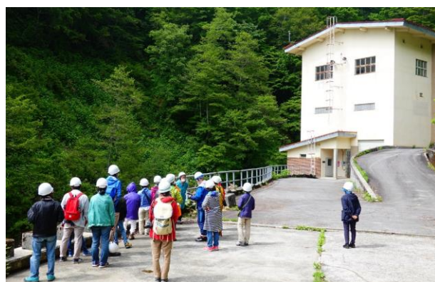
折立発電所は、有峰ダムの建設当初にできたとのことです。
