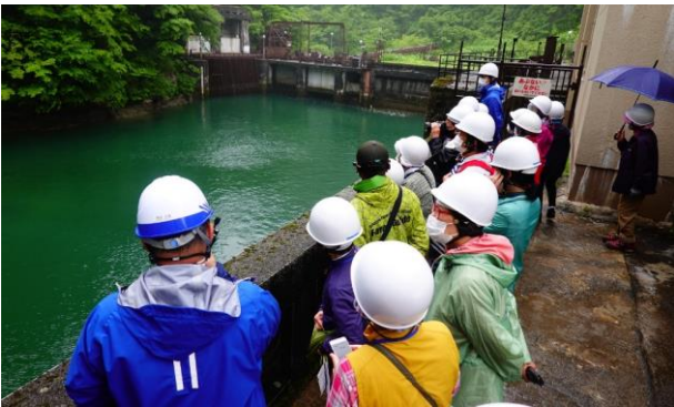
有峰ダムからの水がここで発電され下流の発電所に続きます。
