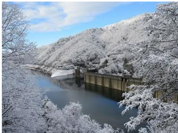
小見線より有峰ダムを眺望 (11/10撮影)
